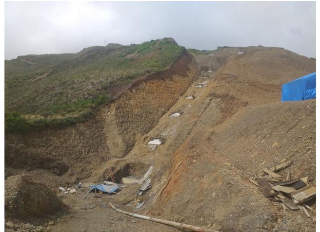
Sistema Umapalca 31-03-22 Obras Superficiales - Tubería Forzada- Hormigonado de Silletas 2da.Etapa T V4-V6
