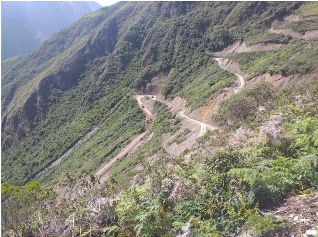
Sistema Umapalca 30-03-22 Obras Superficiales - Vías de Acceso- CCU - CHU Limpieza y Conformación de Plataforma Prog 0+750
