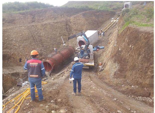
Sistema Umapalca 02-04-22 Obras Superficiales - Tubería Forzada-Armado de enjerradura 2da.Etapa Vertice V3
