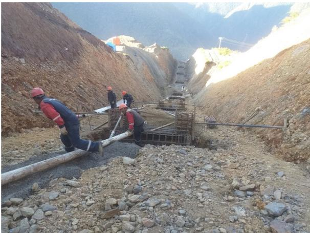
Sistema Umapalca 29-03-22 Obras Superficiales - Tubería Forzada- Hormigonado de Silletas 2da.Etapa T V4-V6
